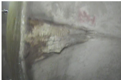
写真-4 左側壁映像例
