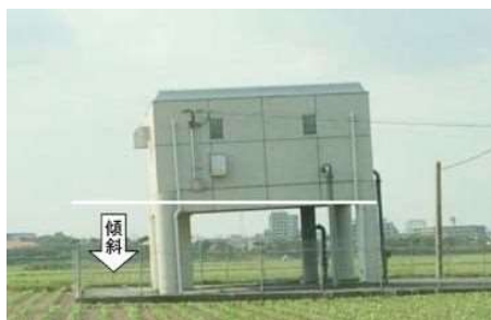
写真-3 井戸ポンプ室建屋Aの傾斜・沈下
