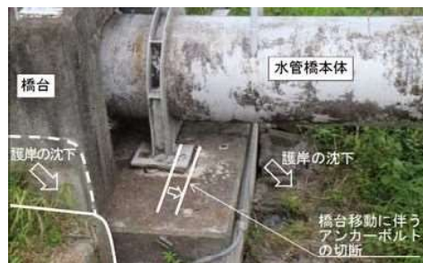
写真-2 護岸沈下・橋台移動に伴う被害
