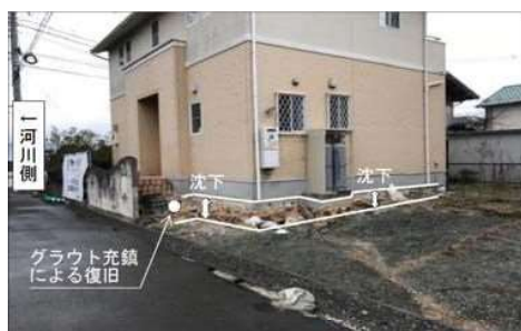
写真-2 沈下の状況 (2)
