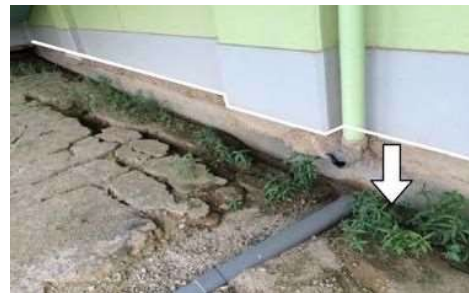
写真-11 構造物周辺の沈下状況
