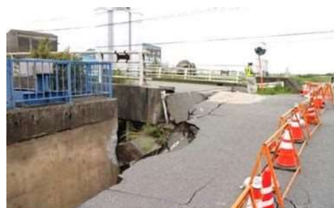
写真-1 道路橋周辺地盤の変状
