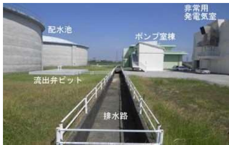
写真-10 A配水場の主要施設
