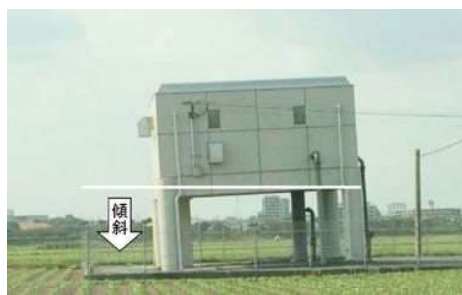
写真7 井戸ポンプ室建屋 A の傾斜・沈下
