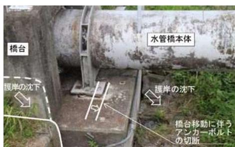
写真6 護岸沈下・橋台移動に伴う被害
