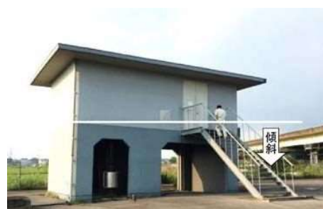
写真8 井戸ポンプ室建屋 B の傾斜・沈下
