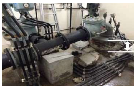
写真9 井戸ポンプ室建屋内の管路設備被害
