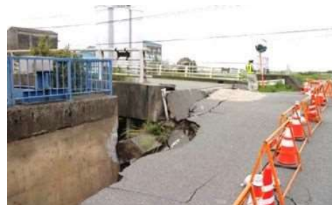
写真-5 道路橋周辺地盤の変状 13)
