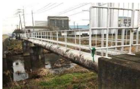
写真-4 水管橋全景
