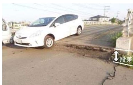
写真-3 道路橋と背面地盤の段差 12)
