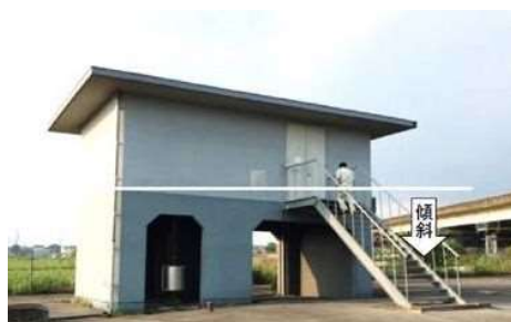
写真-4 井戸ポンプ室建屋Bの傾斜・沈下
