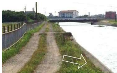
写真-1 沈下の状況（1）
