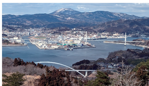
写真2.4 気仙沼市における復旧・復興の状況及び全線開通となった三陸道路
