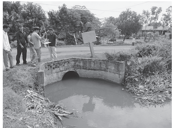
写真-3 現場調査の様子
