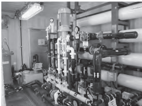
図-3 可搬式海水淡水化施設 (内部)
