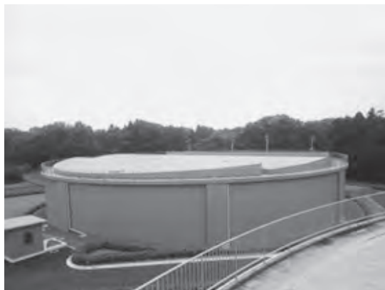
写真－５ 備蓄施設の築造
