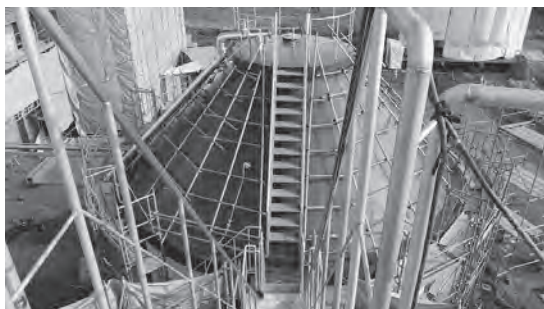
写真-2 し尿処理センターの改築工事の様子 (汚泥消化槽)
