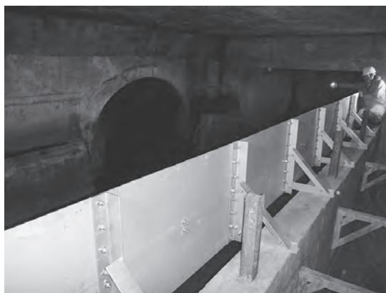
写真-1 水面制御装置設置後の様子
