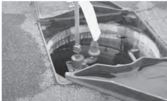
写真－7 応急給水装置
