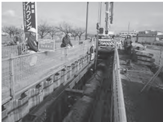
写真－４ 送水管路の更新状況
