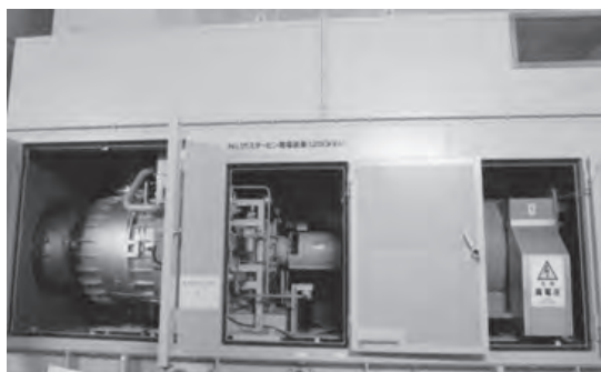
写真－６ 非常用発電機設備整備
