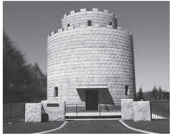
写真-2 緊急遮断弁及び応急給水栓を備えている 共栄調整槽
