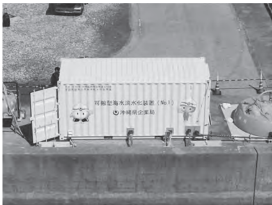
図-2 可搬式海水淡水化施設
