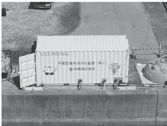
図-2 可搬式海水淡水化施設
