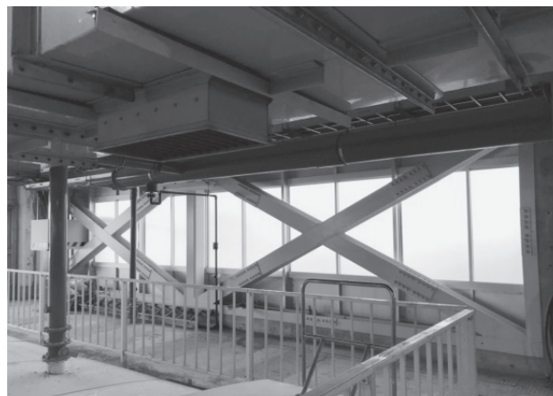
写真-3 建築施設の耐震補強例
