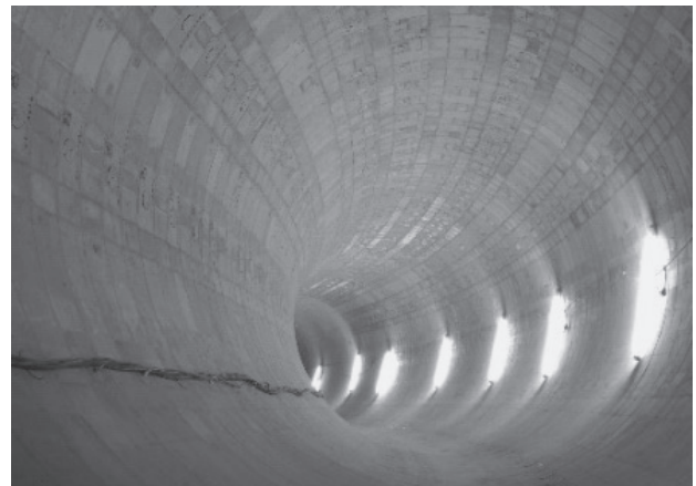
写真－1 浸水対策工事（出島バイパス線 φ4,500）
