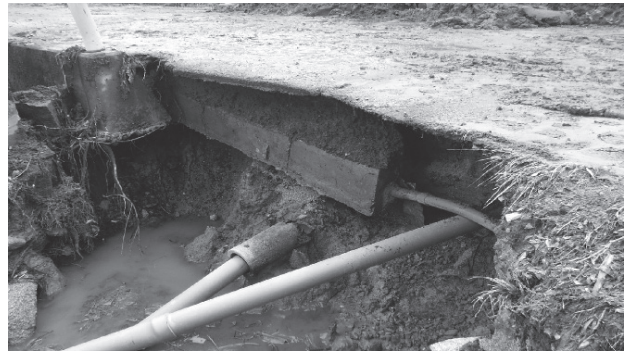
写真－2 集中豪雨によりむき出しになった圧力管
