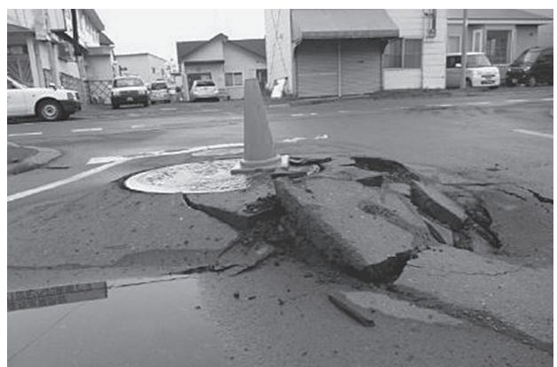
写真-5 被災マンホール
