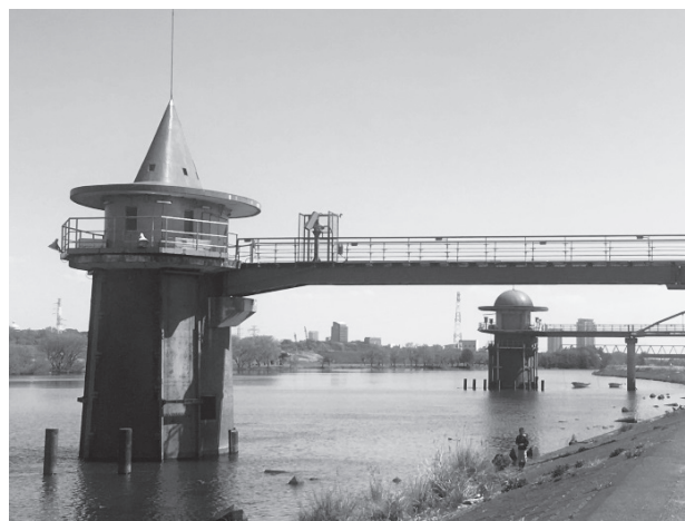
写真-2 金町浄水場第2取水塔（手前）第3取水塔（奥）
