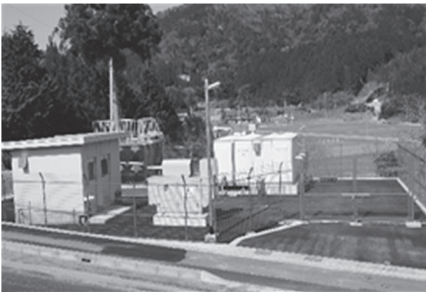
写真-3 完成した鴨阪加圧ポンプ場
