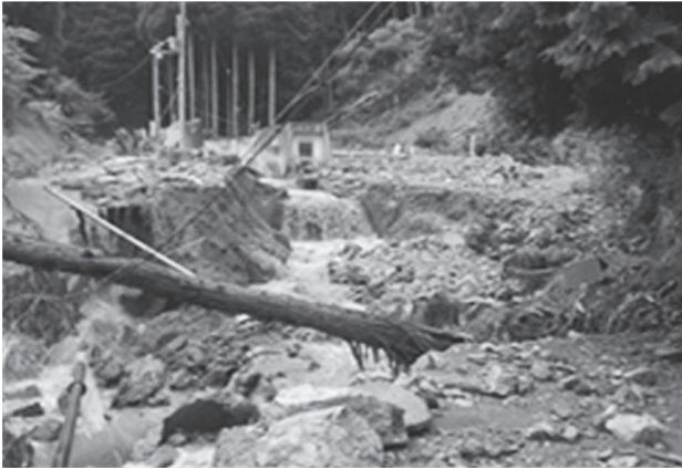
写真-2 被災した鴨阪浄水場
