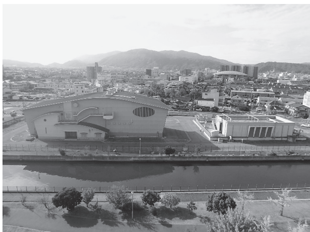
写真-1 中央ポンプ場（左）と中央雨水滞水池（右）
