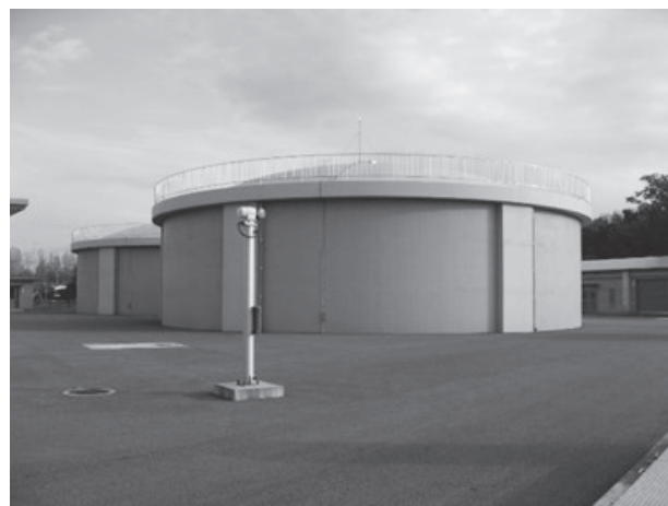
写真－1 平成30年度に完成した木原野配水池
