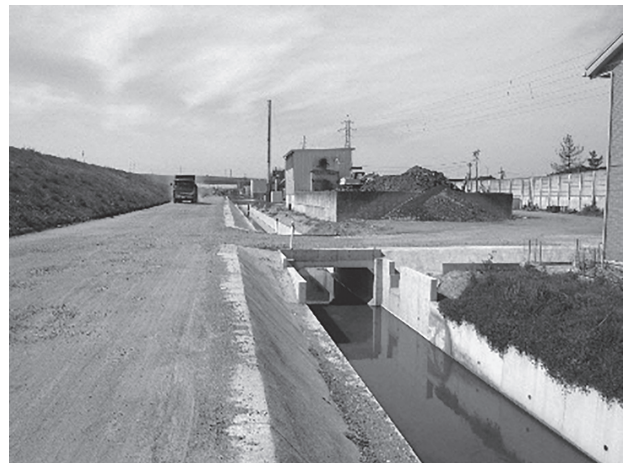
写真-2 蓮花寺東雨水幹線整備
