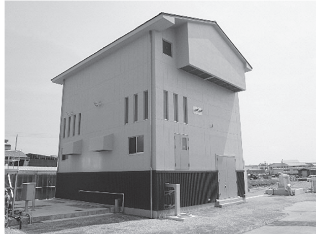
写真-1 住吉ポンプ場
