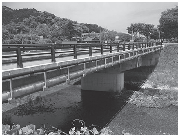
写真-1 施工後写真
