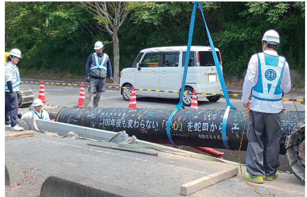
写真-2 タイム送水管布設状況
