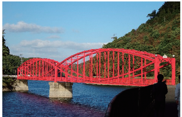
写真-2 南河内橋（2023年）
