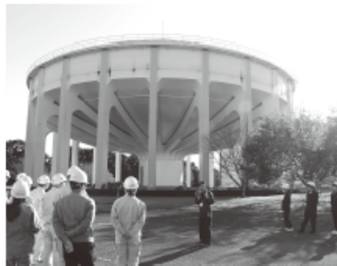
自然流下による供給を支える高架調整池も確認
