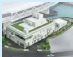
雨水ポンプ場
