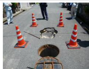
写-1. 下水道管路に起因した道路の陥没事故
