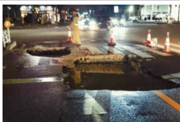
写-1. 下水道管路に起因した道路の陥没事故
