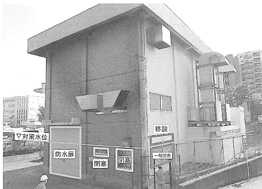
写真－１ 施設の耐水化例
