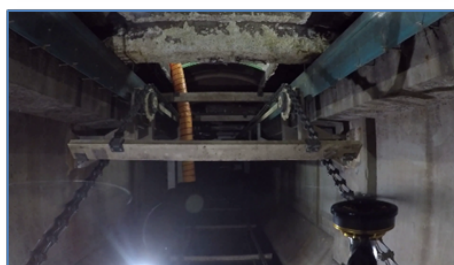
写真-1 上部：管廊での自動飛行状況、 下部：最初沈殿池内での飛行時取得画像
