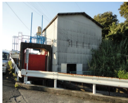
既設ポンプ棟
