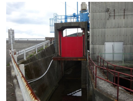
既設流出ゲート
