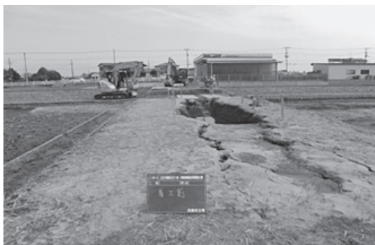
写真-1 東北地方太平洋沖地震時の被害状況
