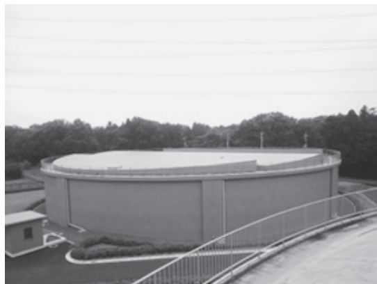
写真－５ 備蓄施設の築造
