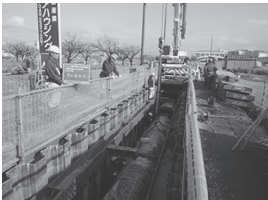
写真－４ 送水管路の更新状況
