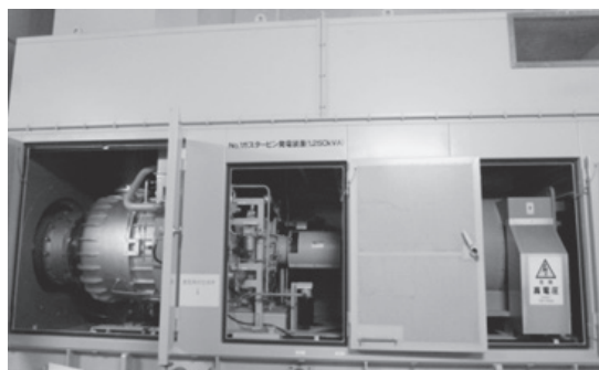
写真－６ 非常用発電機設備整備
