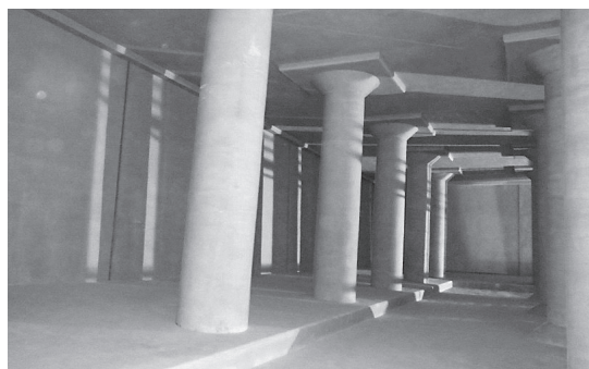
写真-1 配水池の耐震補強工事竣工（寺内配水場）
