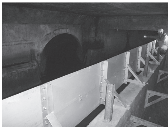
写真-1 水面制御装置設置後の様子
