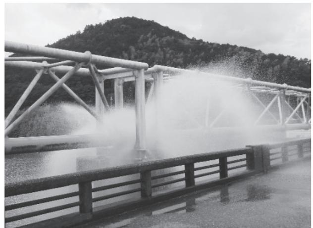
写真-1 本市で発生した配水本管漏水状況
