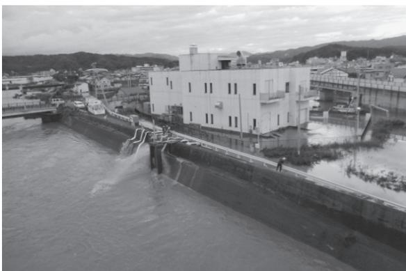
写真-7 ポンプ車による排水状況
