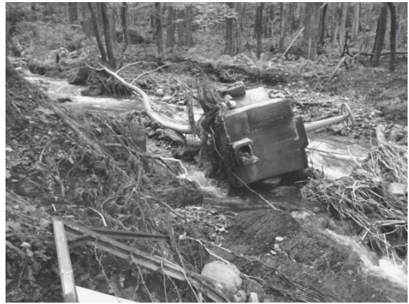
写真－4 小国取水場
