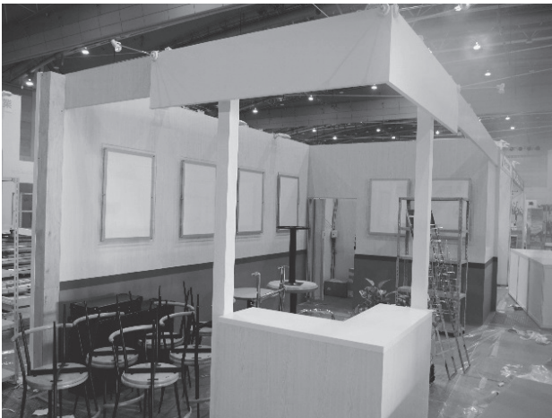
写真-2 ブース製作途中の状況
