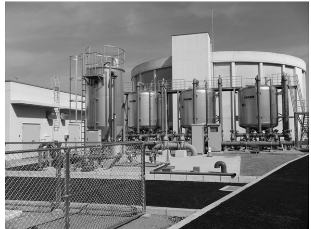
写真－2 湊系配水施設等改修事業
