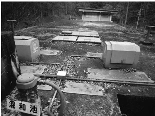
写真－4 幸沢川浄水場
