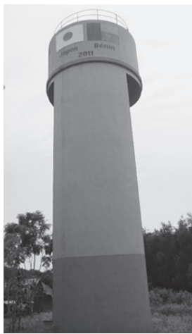
写真－3 高架水槽（レベル2）
