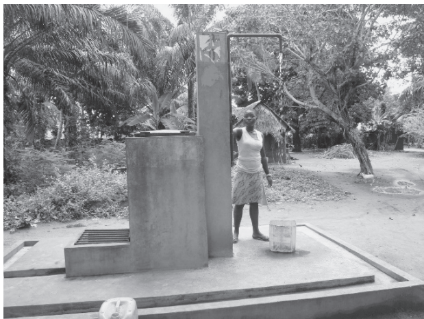
写真－4 共同水栓（レベル2）
