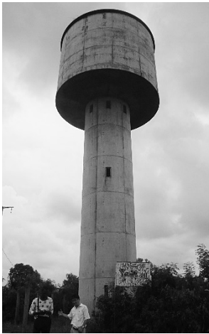
写真-7 給水塔（円筒型）
