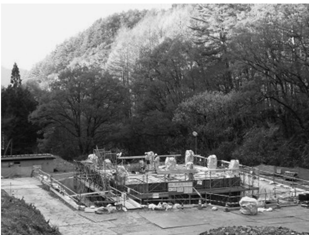
写真－3 伊谷配水池建設状況
