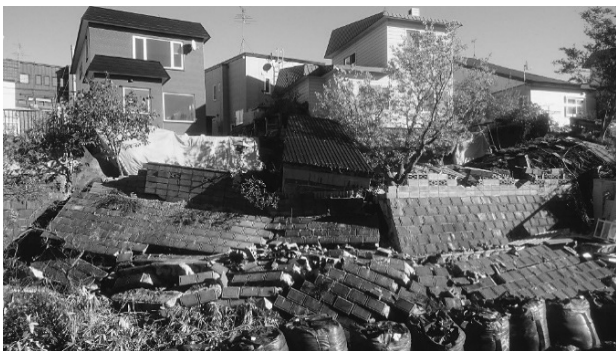
図-4 住宅地の被害状況
