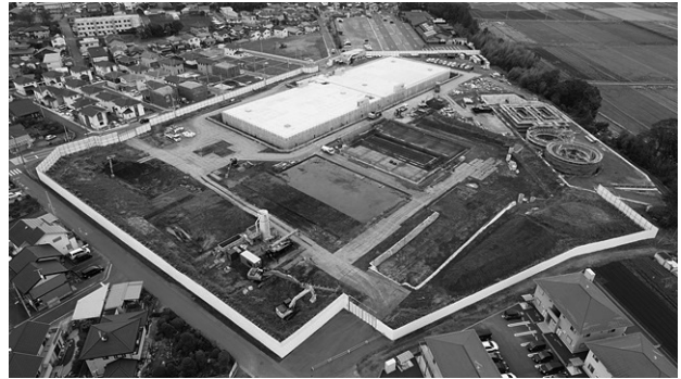
写真-3 上坪浄水場更新工事の施工状況 (令和元年10月24日現在)
