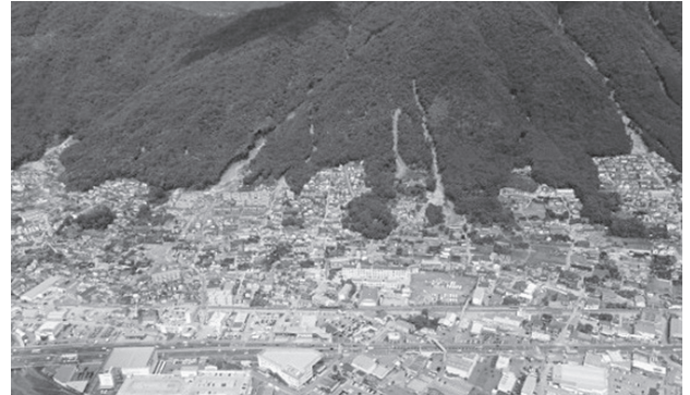
写真-2 安佐南区八木・緑井地区の被災状況
