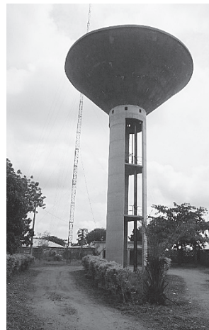
写真－5 給水塔（円錐型）
