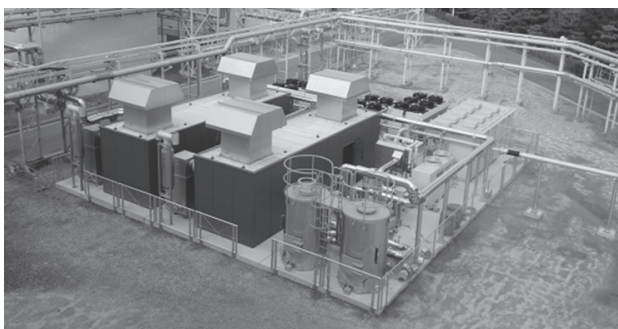
写真－5 消化ガス発電施設
