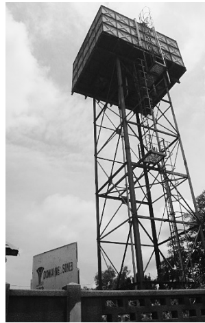
写真-8 給水塔（鋼製）
