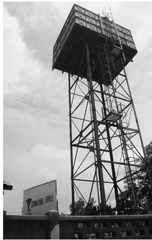
写真-8 給水塔（鋼製）
