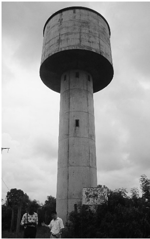
写真-7 給水塔（円筒型）
