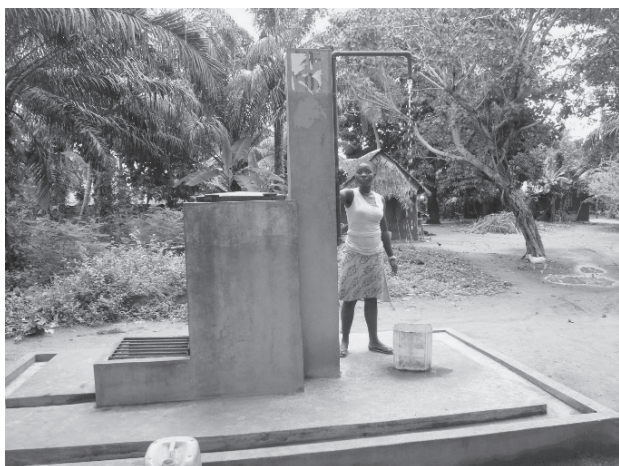
写真－4 共同水栓（レベル2）
