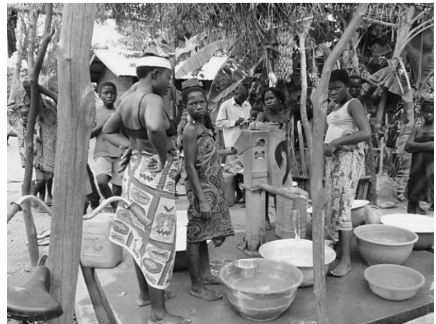
写真－1 手押しポンプ付き井戸（レベル1）
