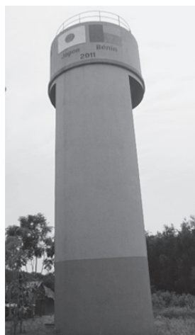
写真－3 高架水槽（レベル2）
