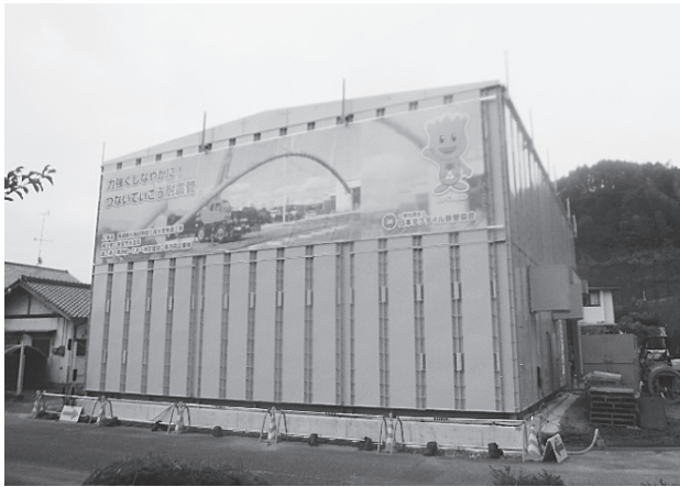
写真-2 防音ハウス
