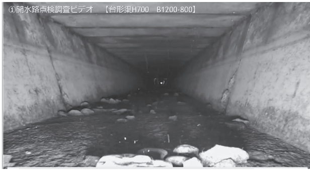
写真-7 トラフ内部
