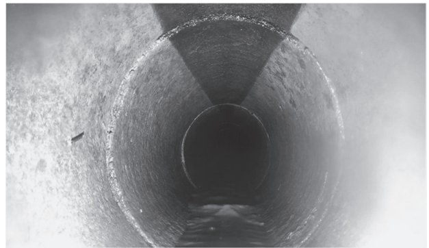
写真-9 貯水池底樋管内部2
