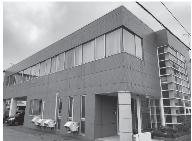
写真-1 オフィス外観
