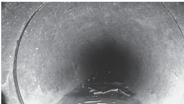
写真-8 貯水池底樋管内部1
