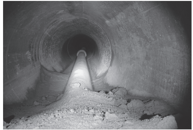
写真-5 内部撮影状況 1
