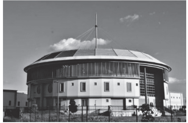
写真-8 ネットワークポンプ場
