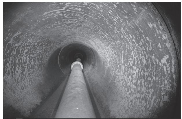
写真-6 内部撮影状況 2
