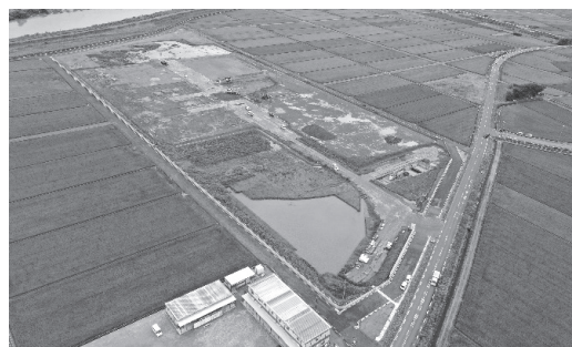
写真-1 統合浄水場建設地の様子
