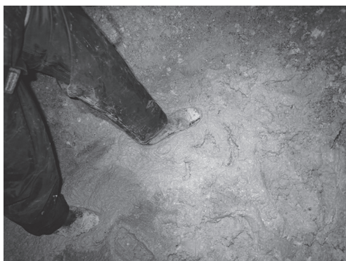
写真-1 特殊人孔劣化状況(パテ状の二水石膏)
