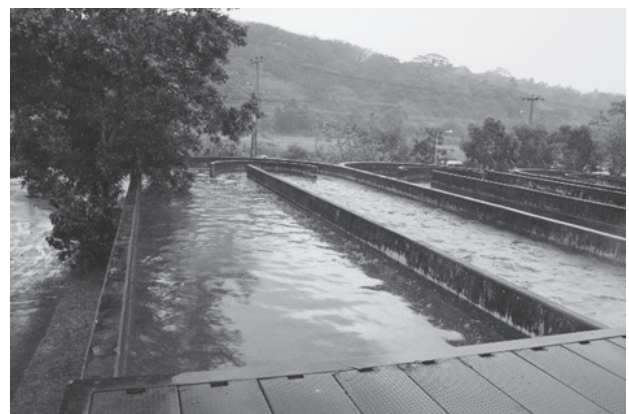
写真－2 コロンボの処理場（オキシレーションディッチ）
