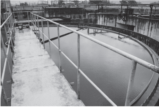
写真-3 コロンボの処理場（最終沈殿池）
