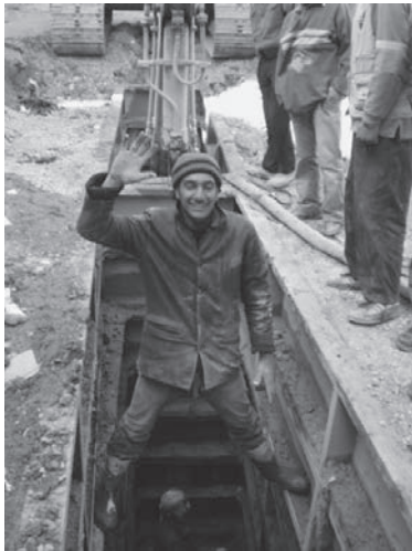
写真-8 たまたま管路工場の現場に遭遇 ノーヘルの陽気な作業員さん
