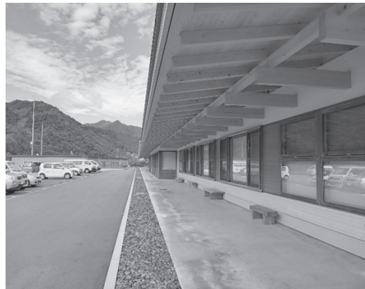
写真-10~11 木曾町新庁舎の外観
