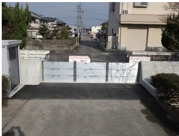
写真-2 各務原浄化センター耐水化工事（R4年度）
