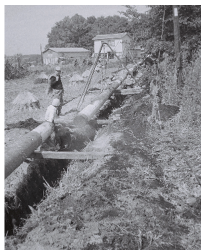
写真－1 昭和42年第2次拡張事業時の導水管布設状況
