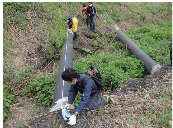
写真-4 導水管定期点検状況
