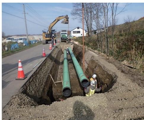
写真－5 導水管布設状況
