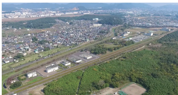
写真-1 各務原浄化センター（木曽川右岸流域下水道事業）
