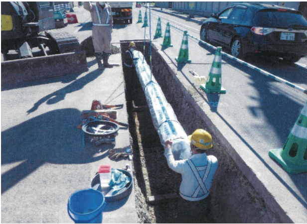
写真-2 配水管更新工事の状況
