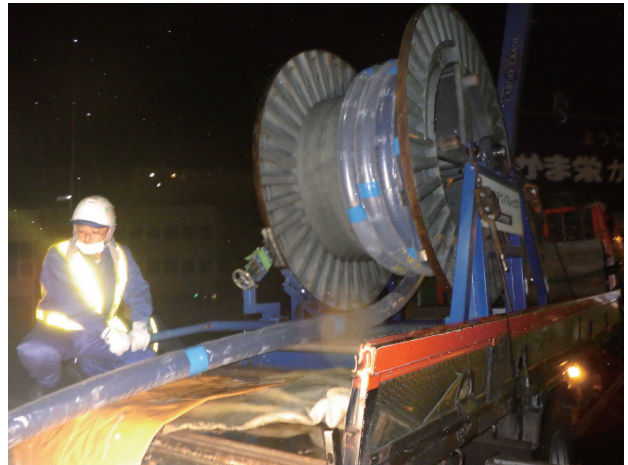
写真-4 SDF工法による工事の状況 (ステンレス・フレキ管の挿入)
