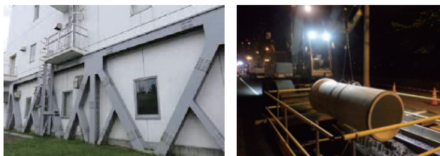
写真-1 水再生プラザや管路の耐震化
