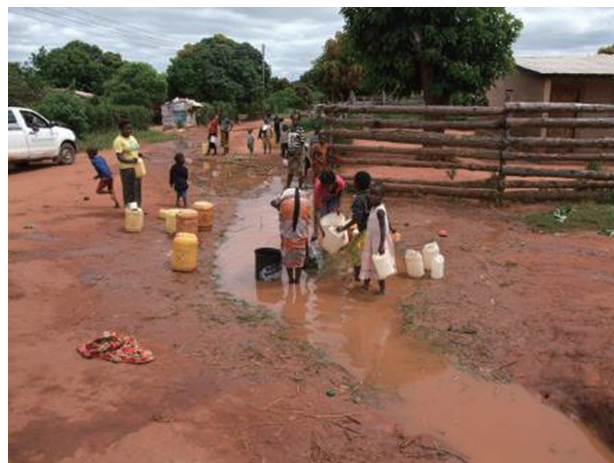
写真-1 漏水した水を汲む状況
