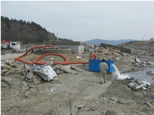
写真-2 既設井戸の応急復旧
