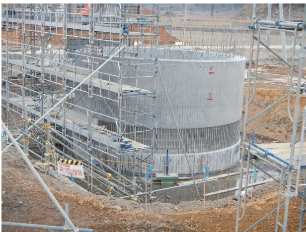
写真-3 新設井戸の施工状況
