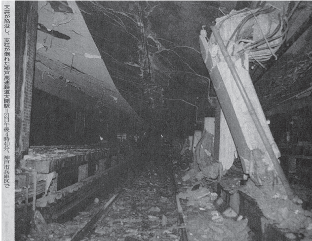
写真-3 阪神大震災時の地下駅舎（大開駅）崩壊の様子 (出典：朝日新聞1995年1月22日朝刊)
