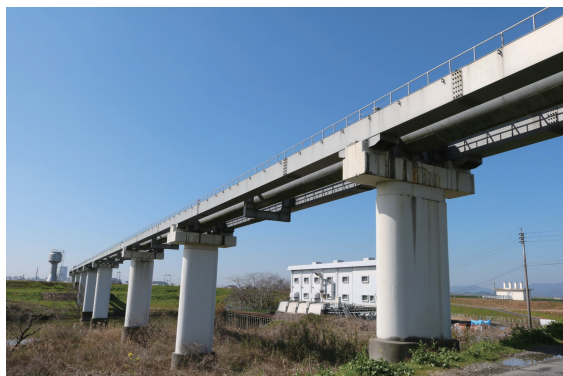
写真-1 福岡導水(思案橋水管橋)
