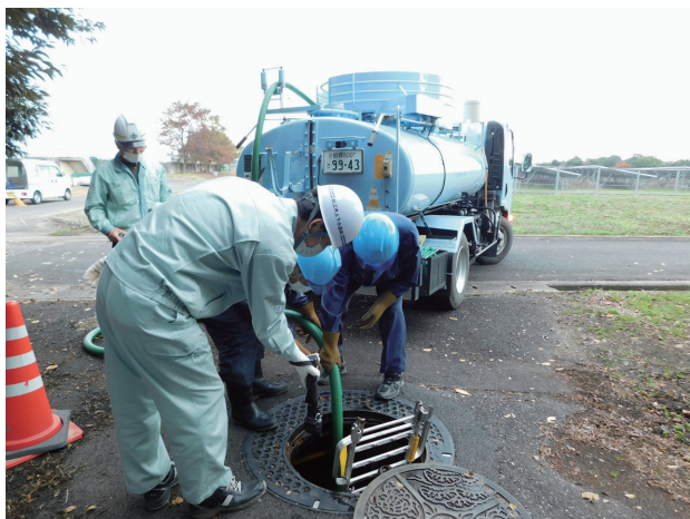
写真-3 バキューム車を使った汚水移送作業の様子
