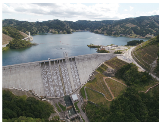
写真-2 五ヶ山ダム
