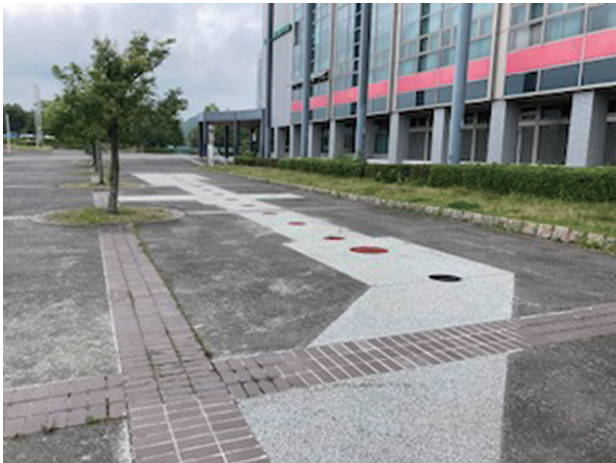
写真－2 工事完了後の現場写真
