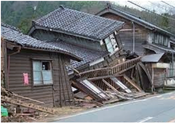
写真-2 能登半島地震での被害状況
