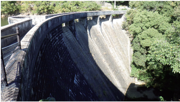
写真-2 久山田貯水池堰堤
