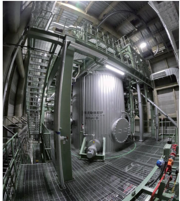
写真-4 改築した1号汚泥焼却炉
