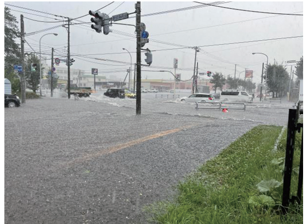
写真-3 局地的豪雨による道路冠水
