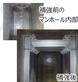
写真-2 マンホールの耐震補強
