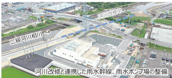
写真-3 天神排水区ポンプ場整備 (津市)
