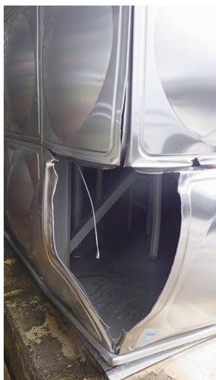
写真-2 配水池下部のパネル剥離状況
