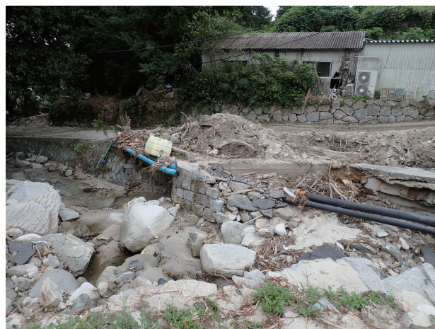
写真－1 被災写真
