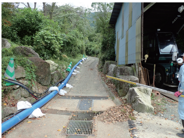
写真-3 応急復旧状況（配水用ポリエチレン管）
