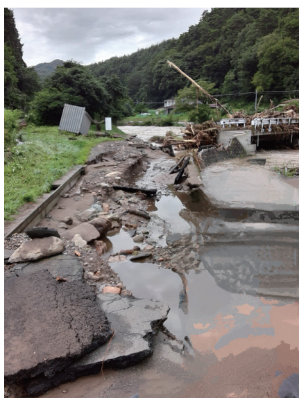
写真-2 降雨災害の緊急現地確認 （災害時はどんな時でも出勤！）
