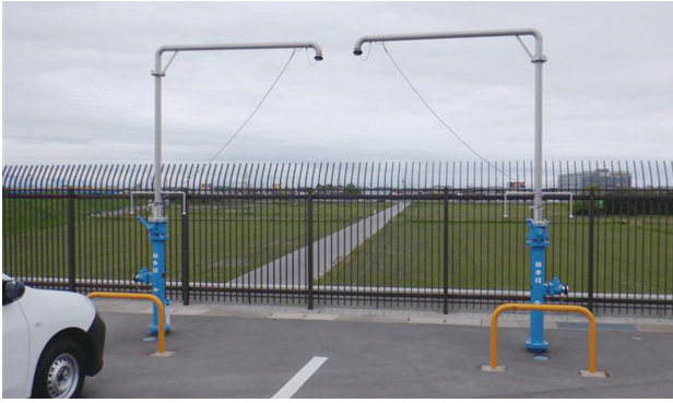
写真-3 給水車専用給水栓（海部広域調整池）
