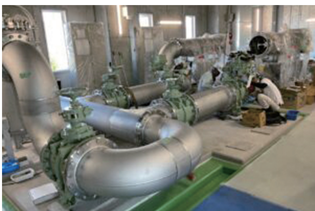
写真－２ 紫外線処理設備
