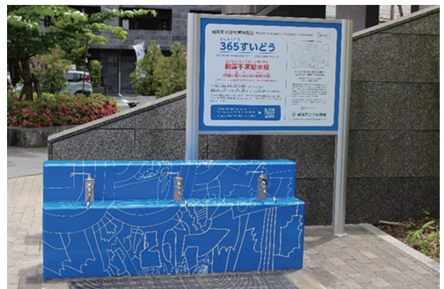
写真－3 365すいどう（耐震不凍給水栓） 第1号基
