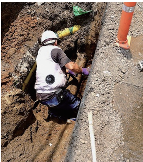
写真－２ 本管漏水の修繕
